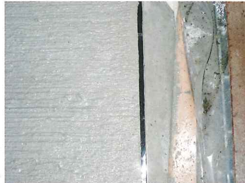
◎コンクリート打設後の状況
