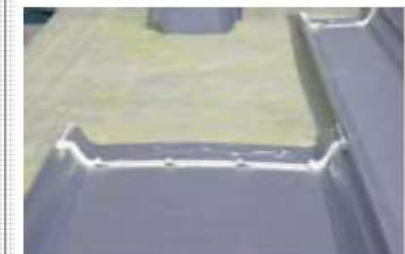
鋼板屋根のつなぎ目の止水
